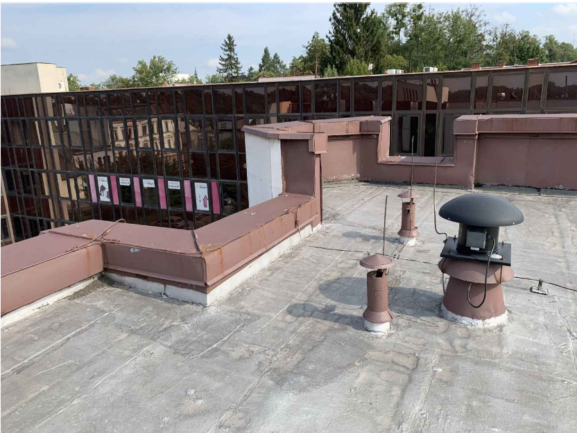
ZVÝŠENÁ ČÁST ATIKY NAD KRAJNÍ SCHODIŠŤOVOU VĚŽÍ
