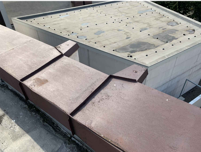
OPLECHOVÁNÍ ATIKY V MÍSTĚ STÁVAJÍCÍCH PILASTRŮ
